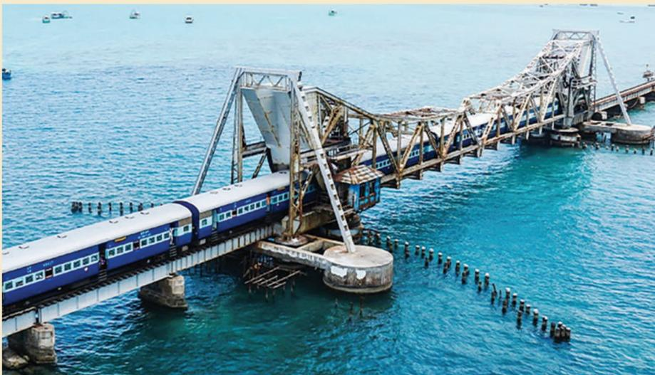
**2.08 किलोमीटर लंबे इस पुल का निर्माण रेल विकास निगम लिमिटेड (RVNL) कर रहा है। इस पुल के वर्टिकल लिफ्ट यानी उठाने वाला हिस्से को ऊपर ले जाने वाले 'लिफ्ट स्पैन' का आकार 72.5 मीटर लंबा, 16 मीटर चौड़ा है और इसका वजन 550 टन है। आरवीएनएल को इस हिस्से को रामेश्वरम तट से 450 मीटर दूर समुद्र तक पहुंचाने में बड़ी चुनौती का सामना करना पड़ रहा है।**
